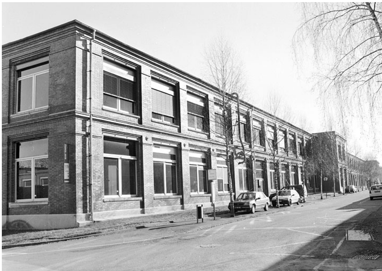
Atelier de finissage : façade ouest.
