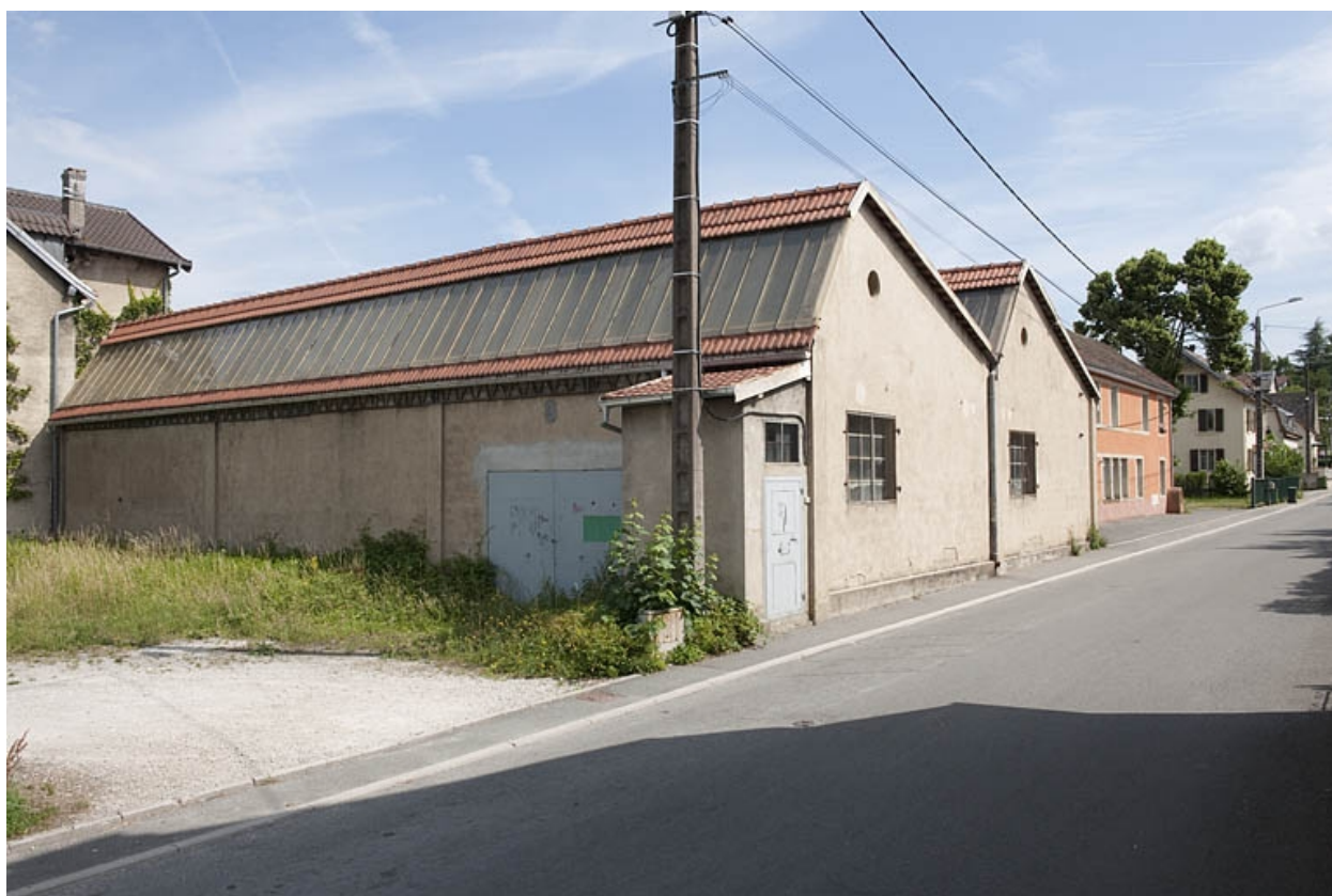
Atelier de fabrication. Extension occidentale.
