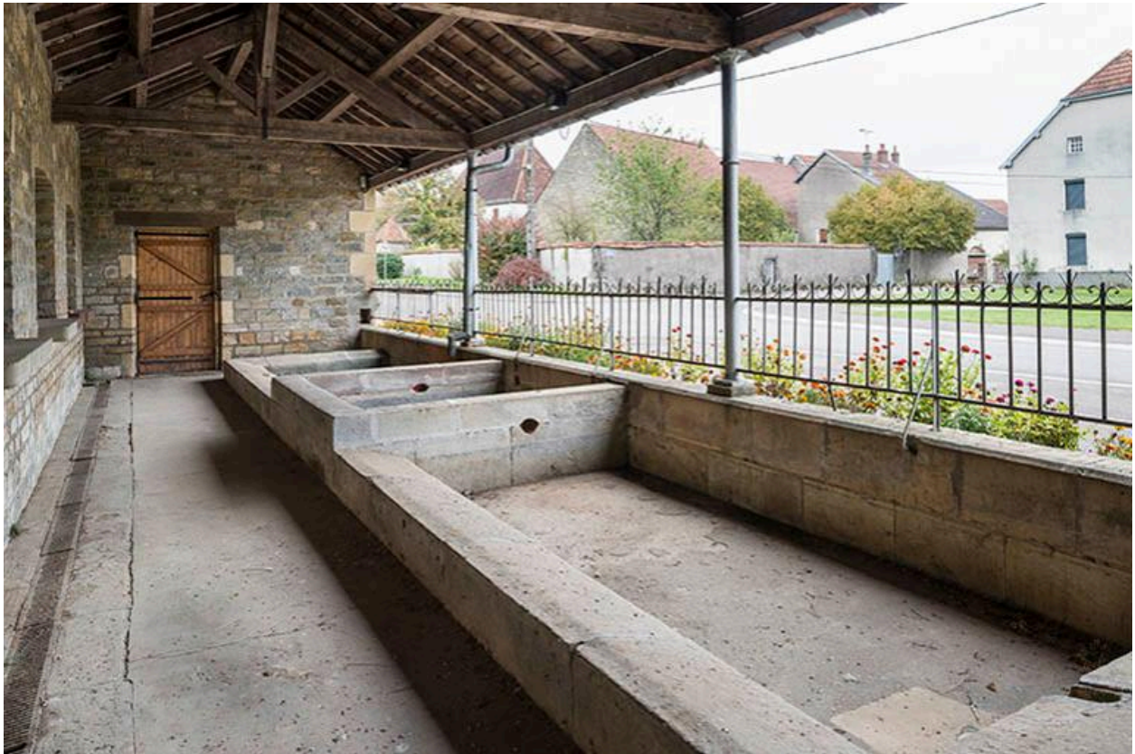
Lavoir communal: les trois bassins et la galerie des laveuses.
