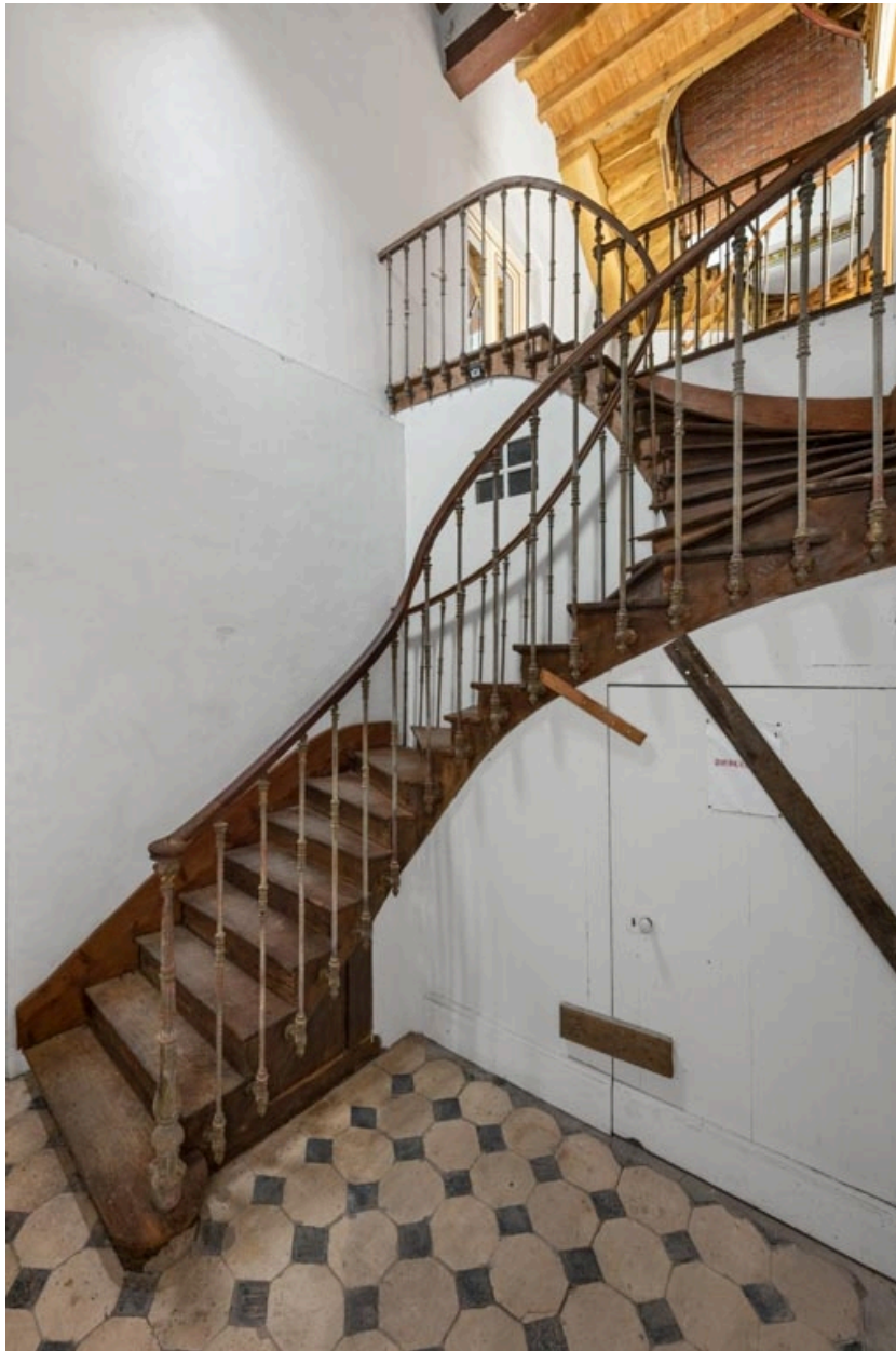
Corps sud : escalier desservant le 1er étage.
