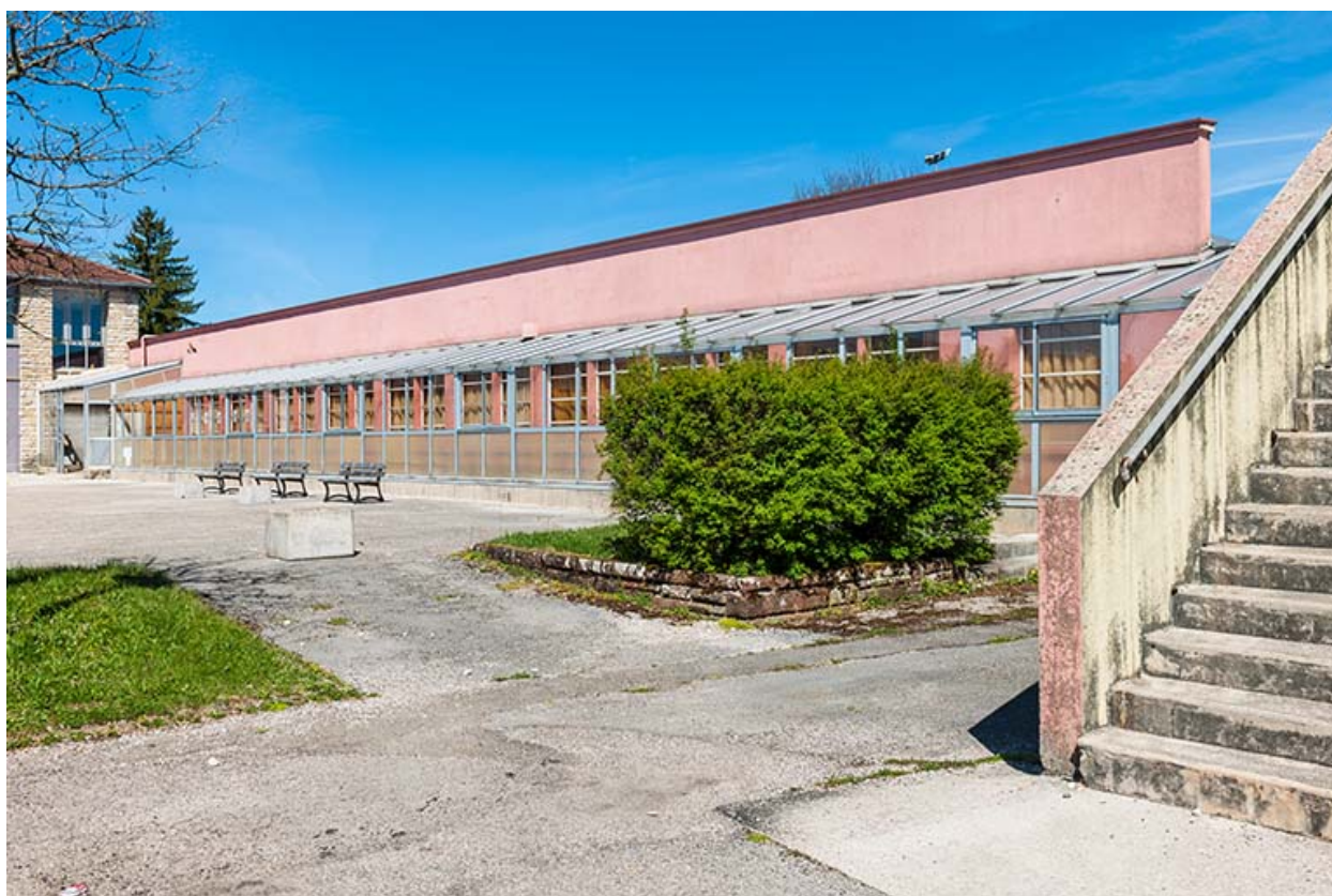
Atelier, site avenue Edouard Herriot : façade antérieure.
