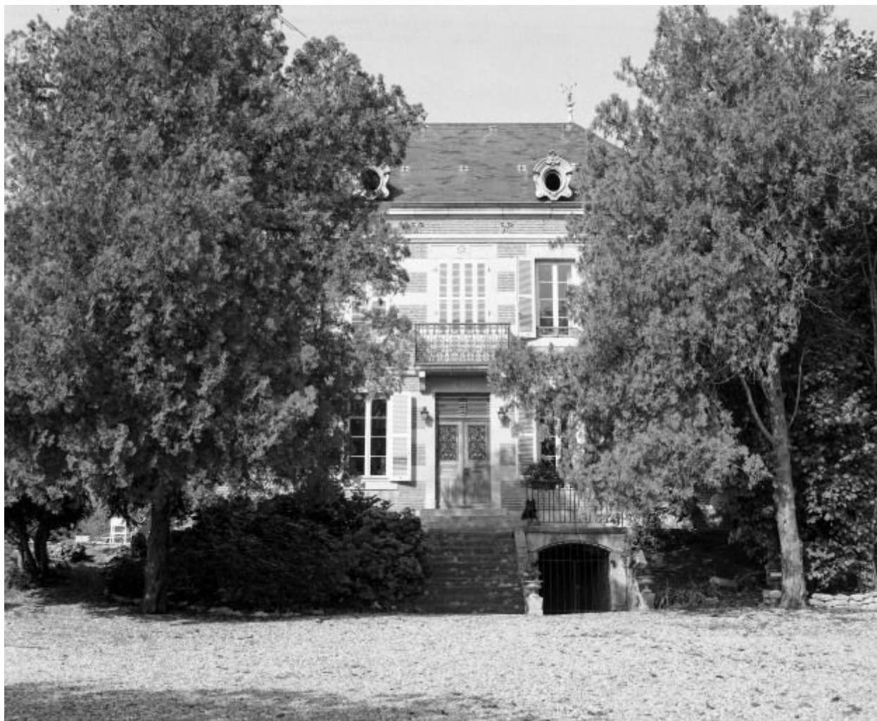
Vue d'ensemble d'une maison (cada. 1969, sect. D, parc. 246).
