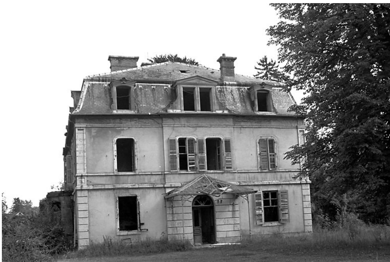
Demeure d'industriel dite château Bornèque en 1981 (incendié en 1979) : Façade sur parc.SRI. Enquête régionale sur les bâtiments industriels (1979-1981).
