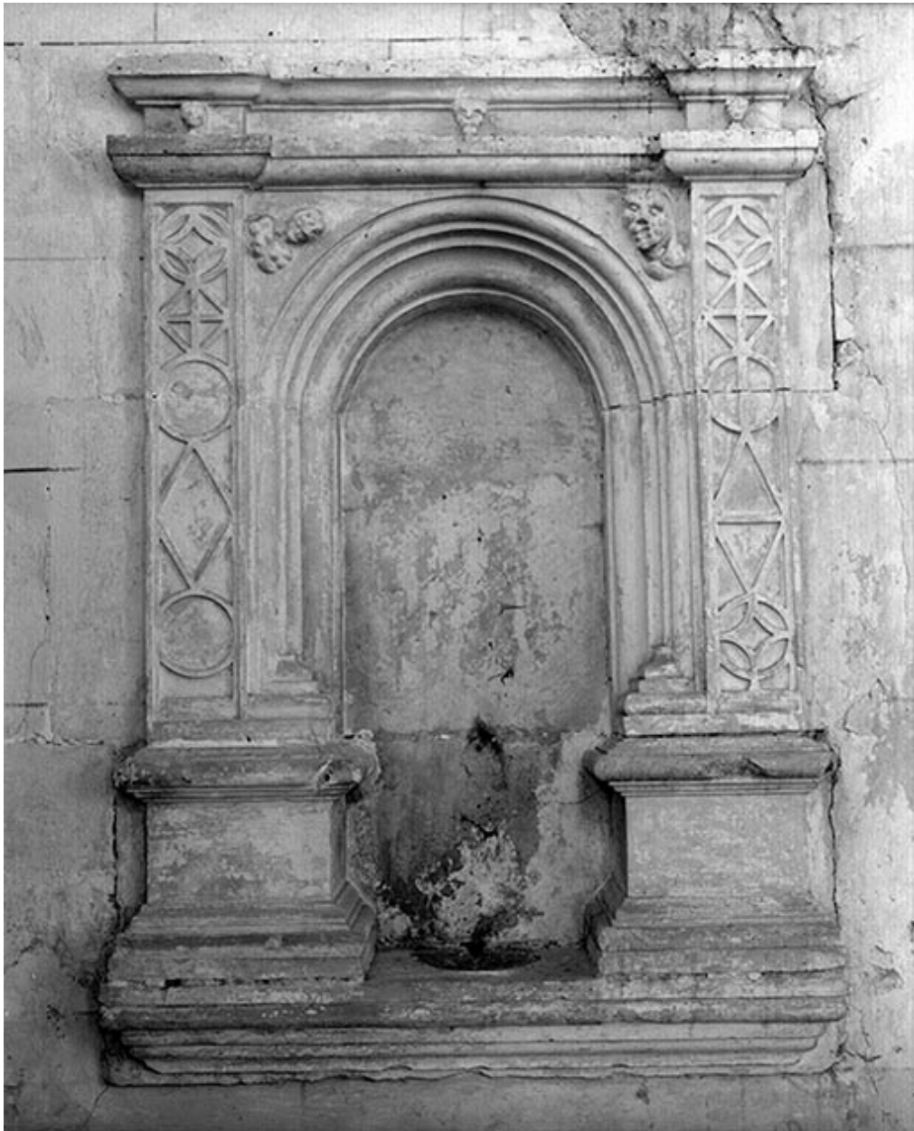
Collatéral droit, 2e travée. Lavabo encastré dans le mur droit.
