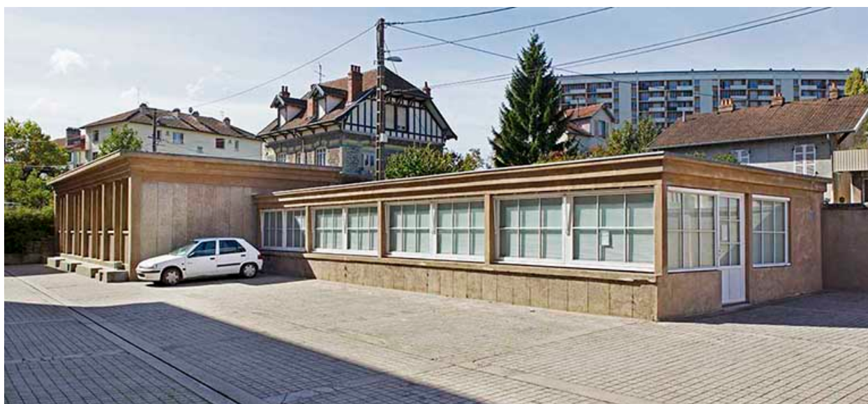
Garages : façades antérieure et latérale droite.
