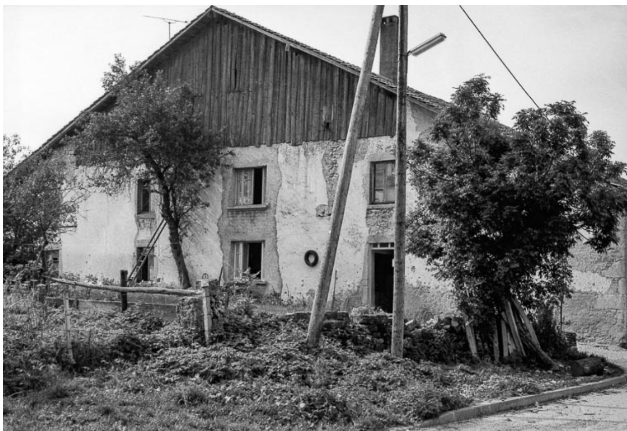
Ferme : façade antérieure.
