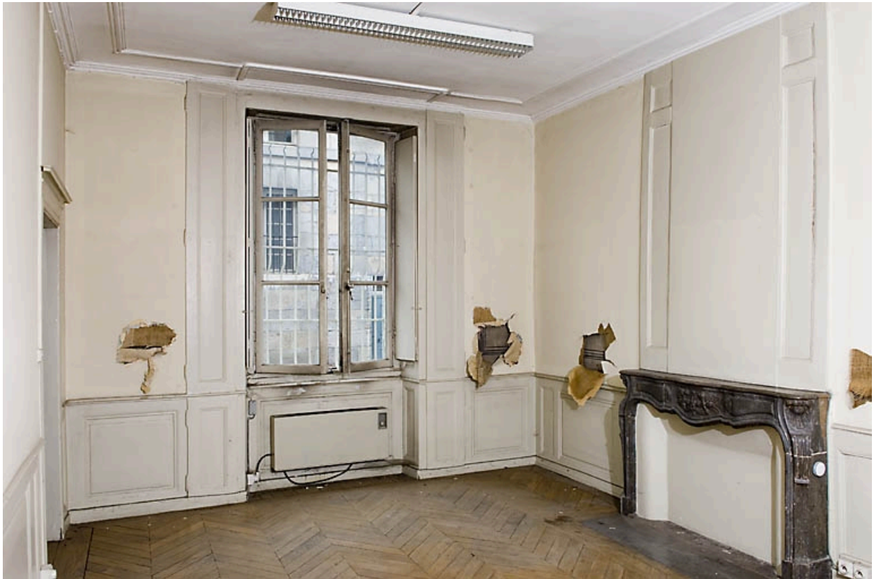
Vue d'ensemble d'une pièce en rez-de-chaussée à gauche de l'escalier principal.
