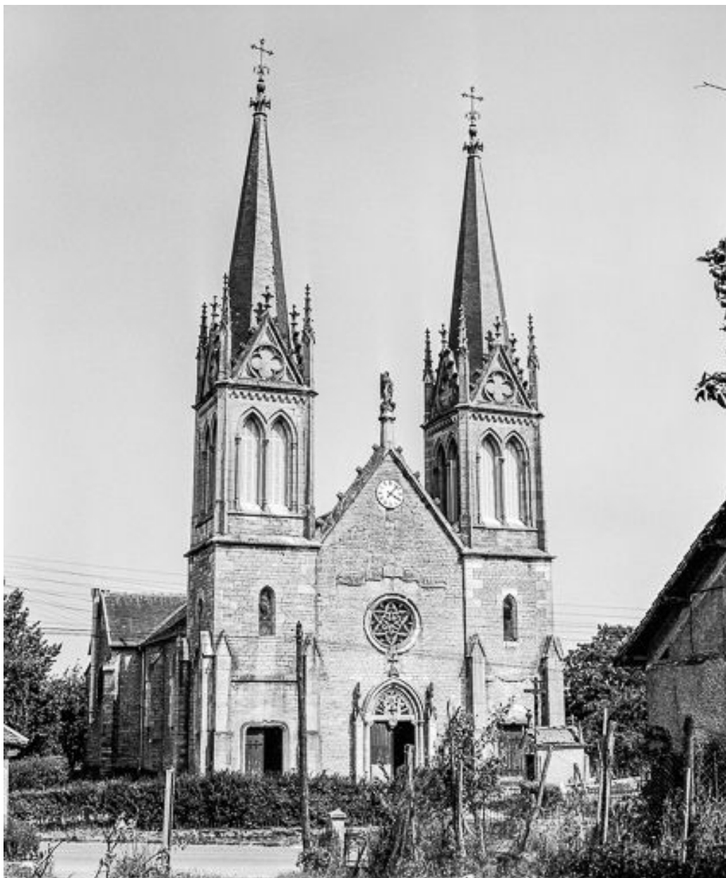
Extérieur : façade antérieure.
