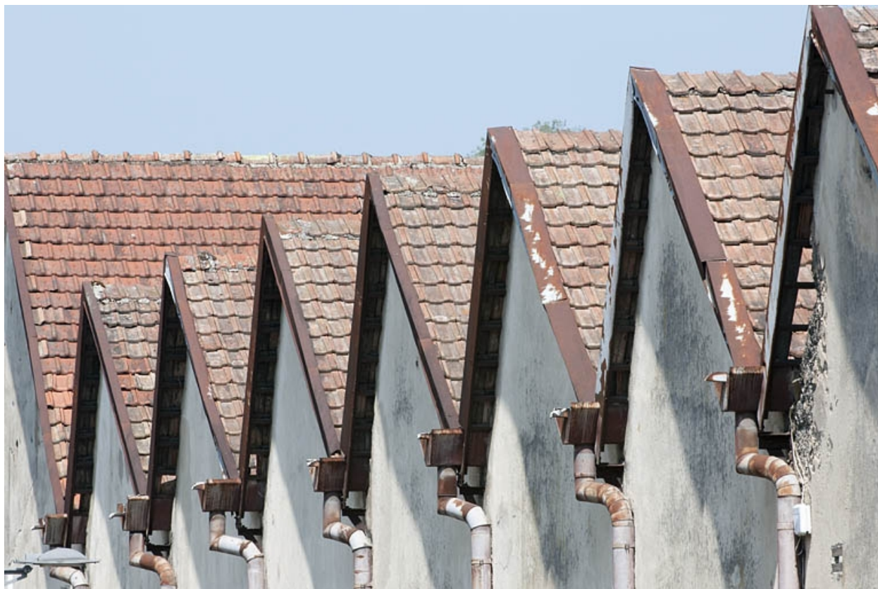
Sheds de l'atelier de laitonnerie.
