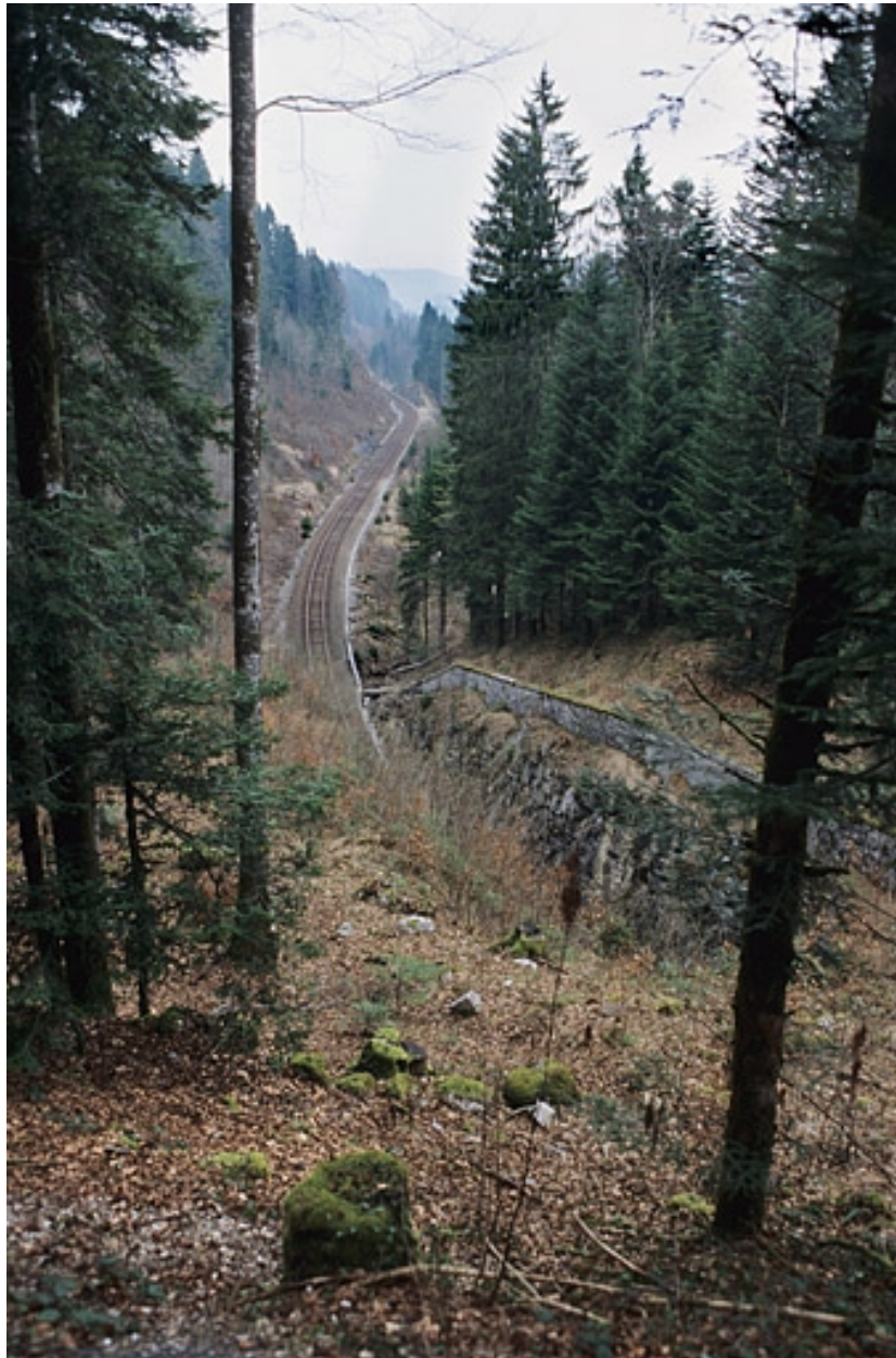
Tranchée et mur de protection côté Andelot-en-Montagne.
