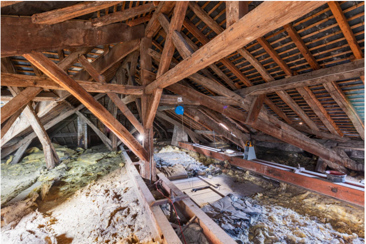
Comble à surcroît.
