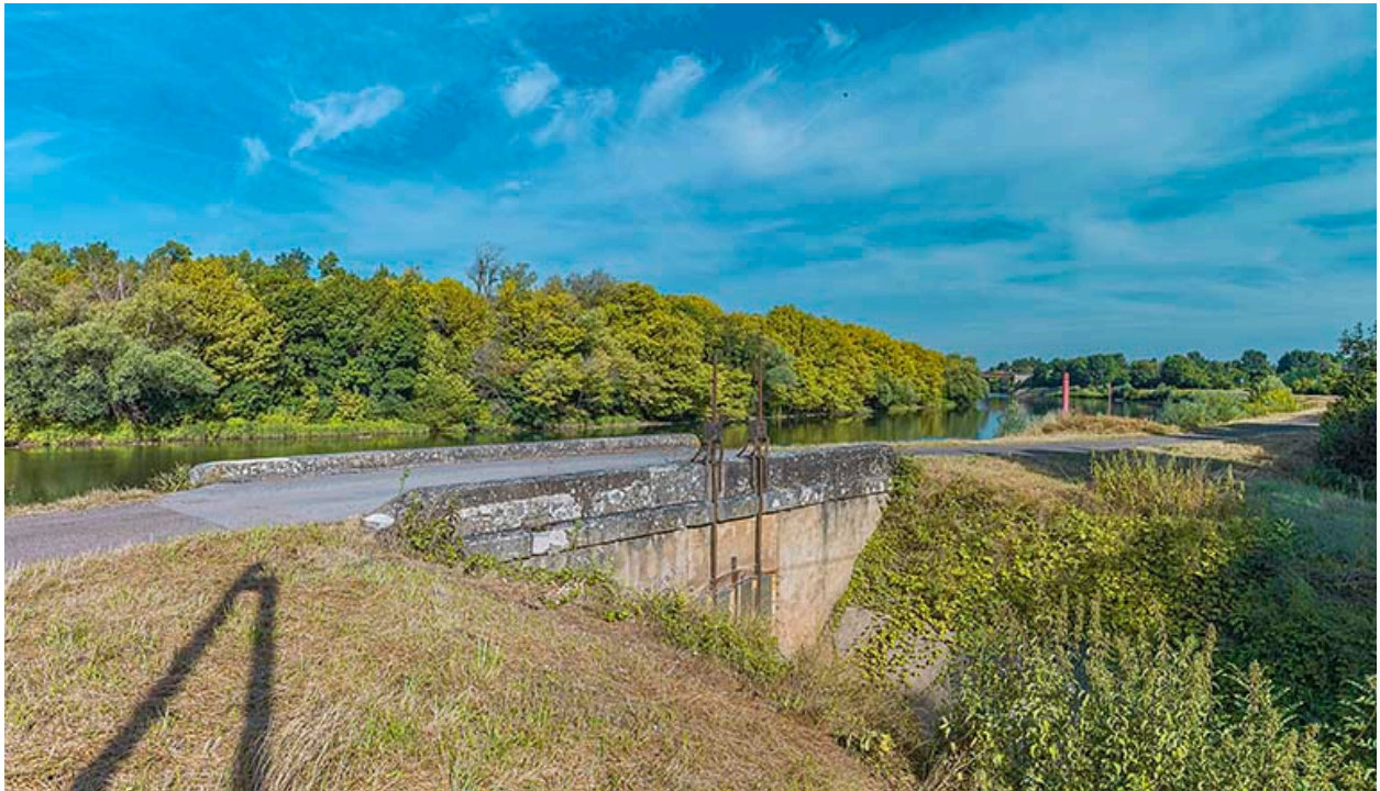
Vue d'ensemble du ponceau.
