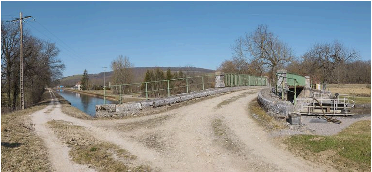
Le pont sur écluse vu d'amont.
