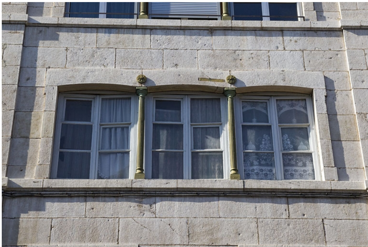
Détail d'une baie horlogère du premier étage.
