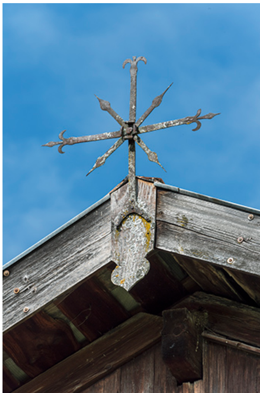
Façade antérieure : croix de faîtage.
