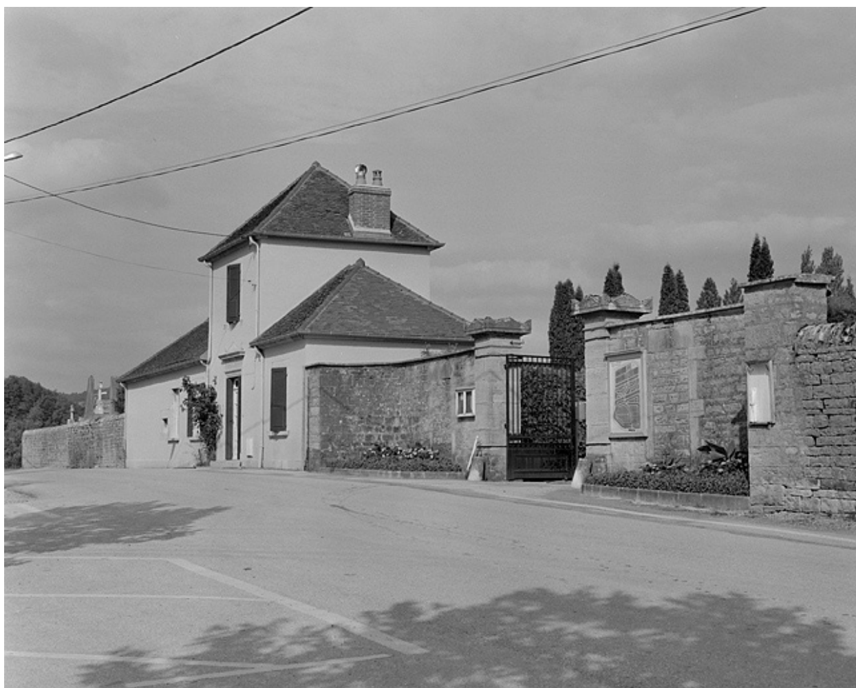
Portail d'entrée et maison du gardien.
