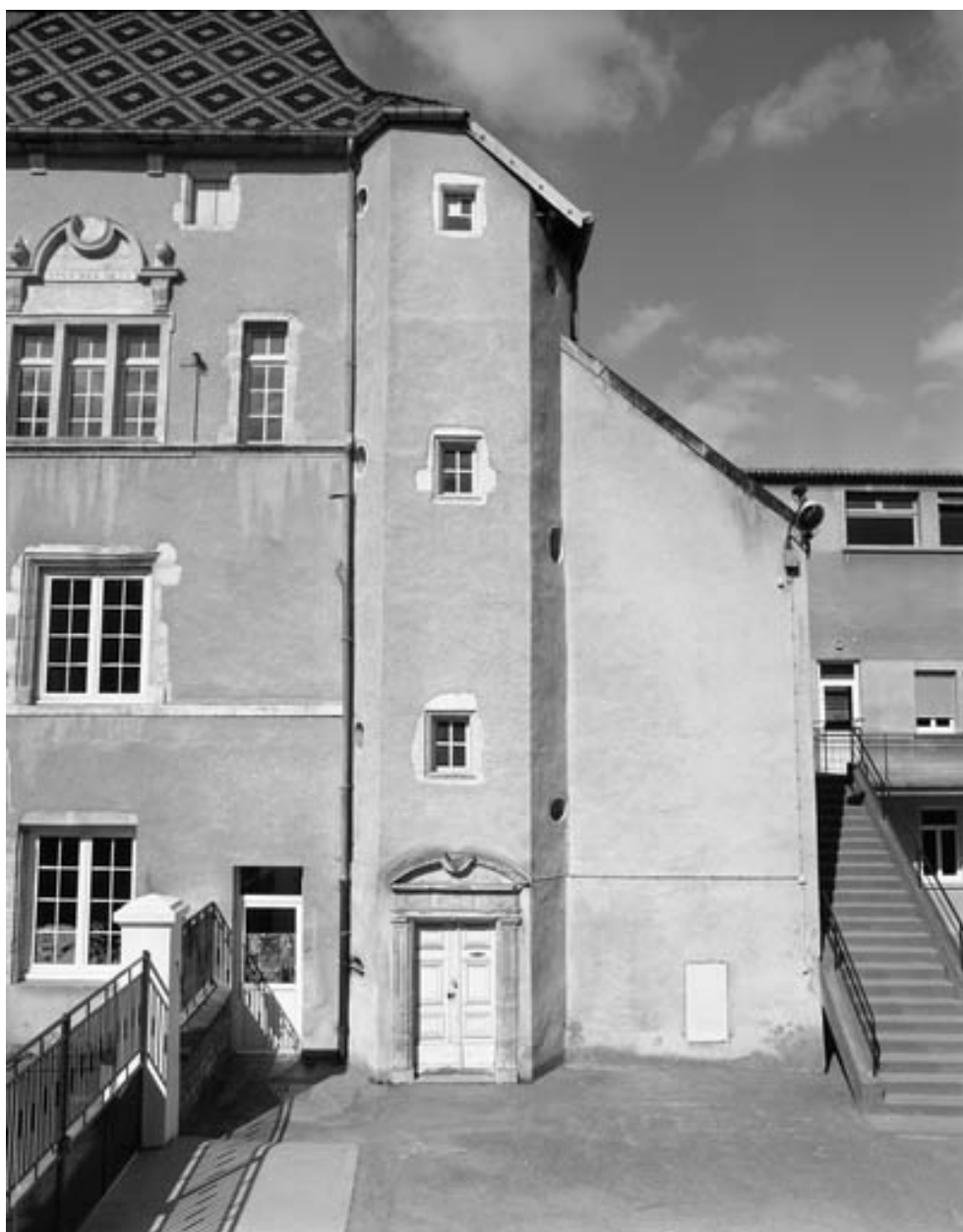
Détail de la tour d'escalier, de face.
