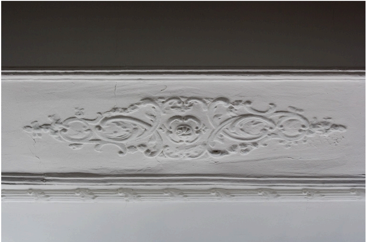
Intérieur, premier étage : détail d'un décor sur une poutre du plafond, chambre à gauche du salon.
