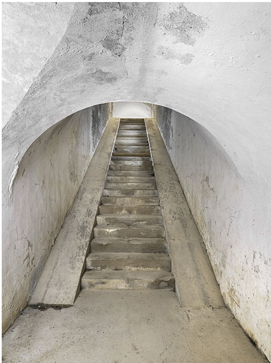
Escalier-rampe, vue montante.
