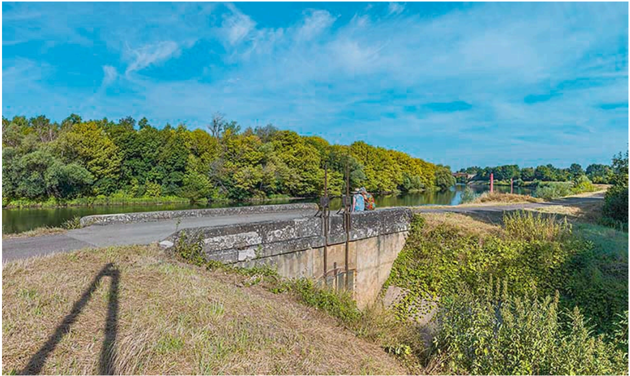
Vue d'ensemble du ponceau.
