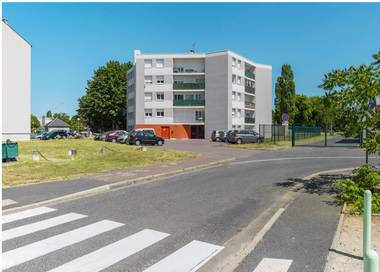
Bâtiment X, façades sud-ouest.
