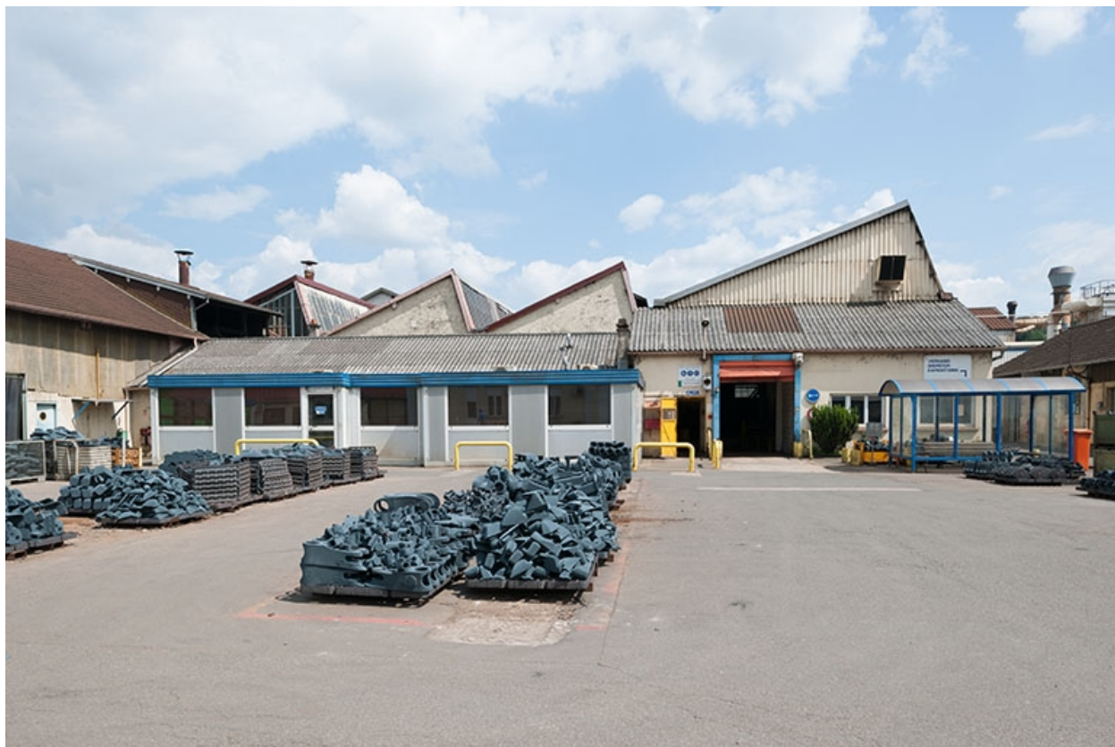
Stockage de pièces moulées dans la cour.
