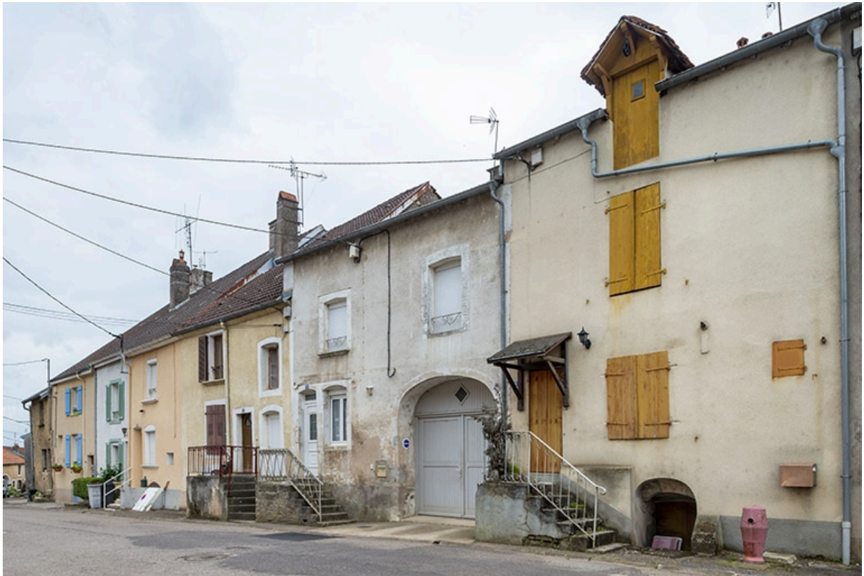
Rue Thiers, alignement du côté pair devant le n° 34, vue vers le nord-est.
