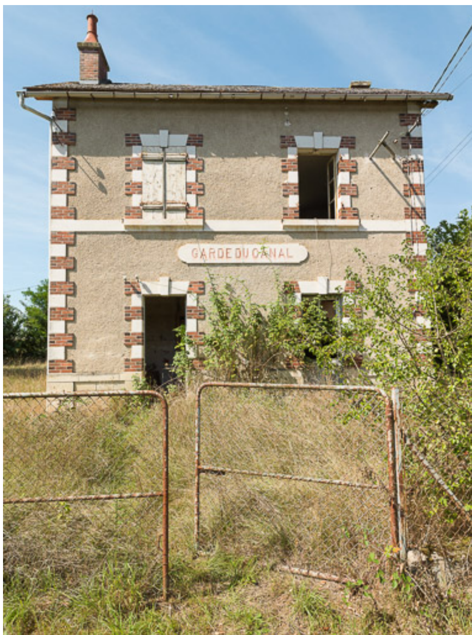
Vue d'une maison de barragiste.
