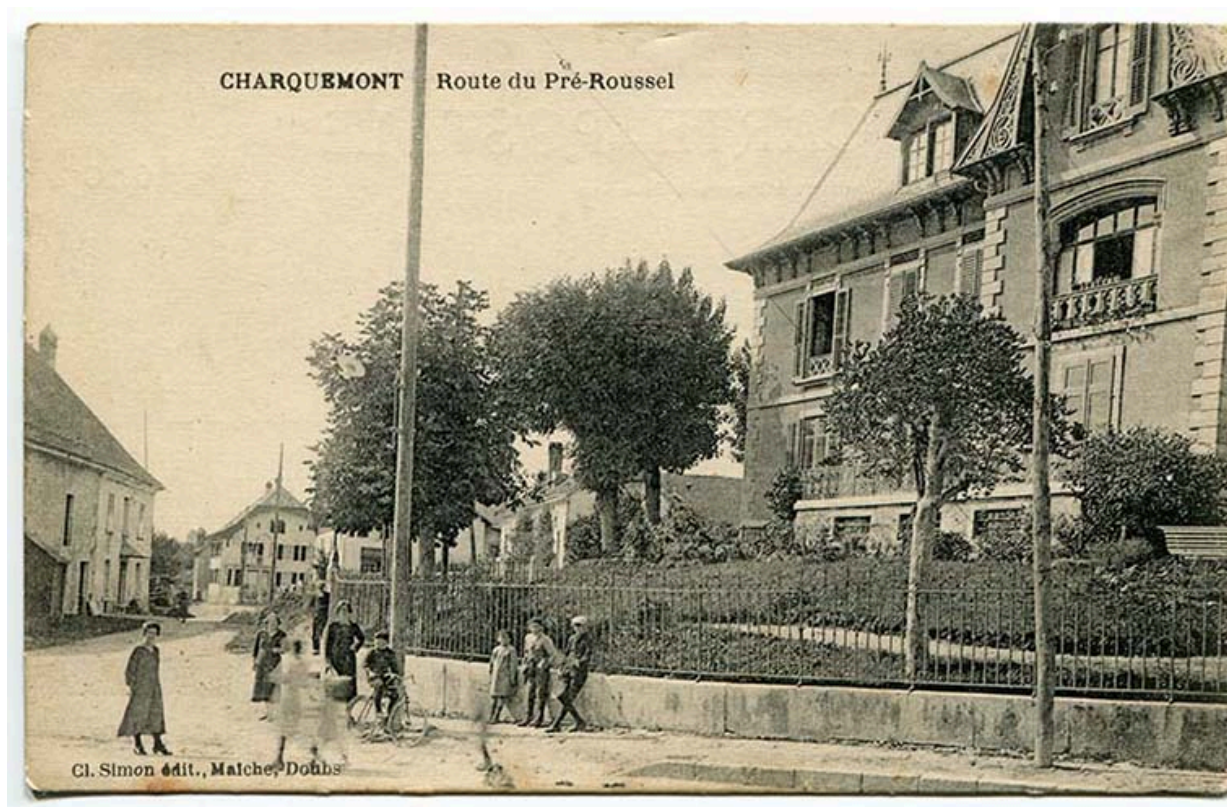
Charquemont. Route du Pré-Roussel [rue du Château], 1er quart 20e siècle
