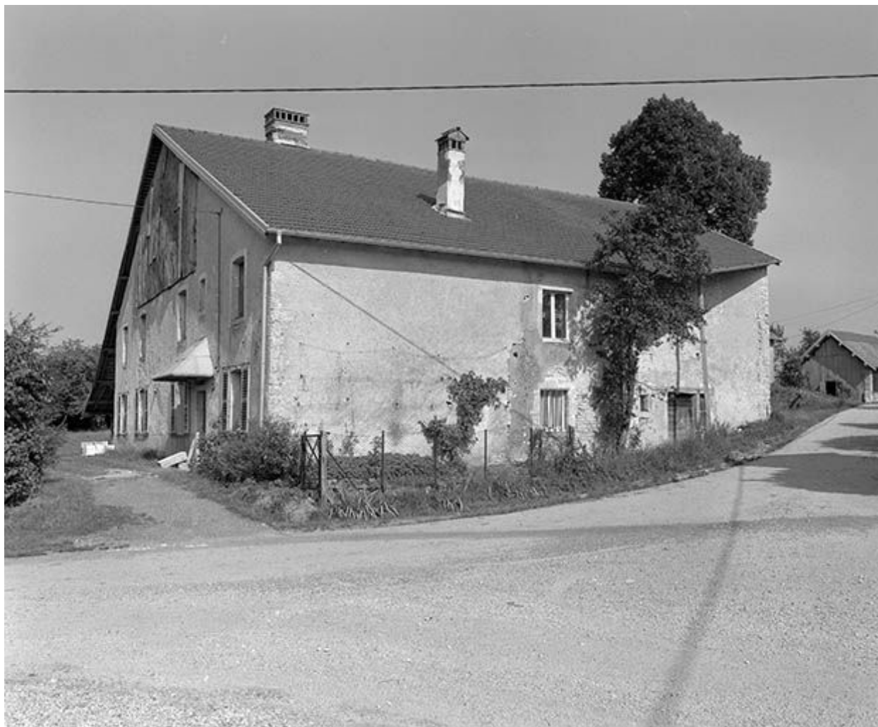
Façade antérieure et face latérale droite.
