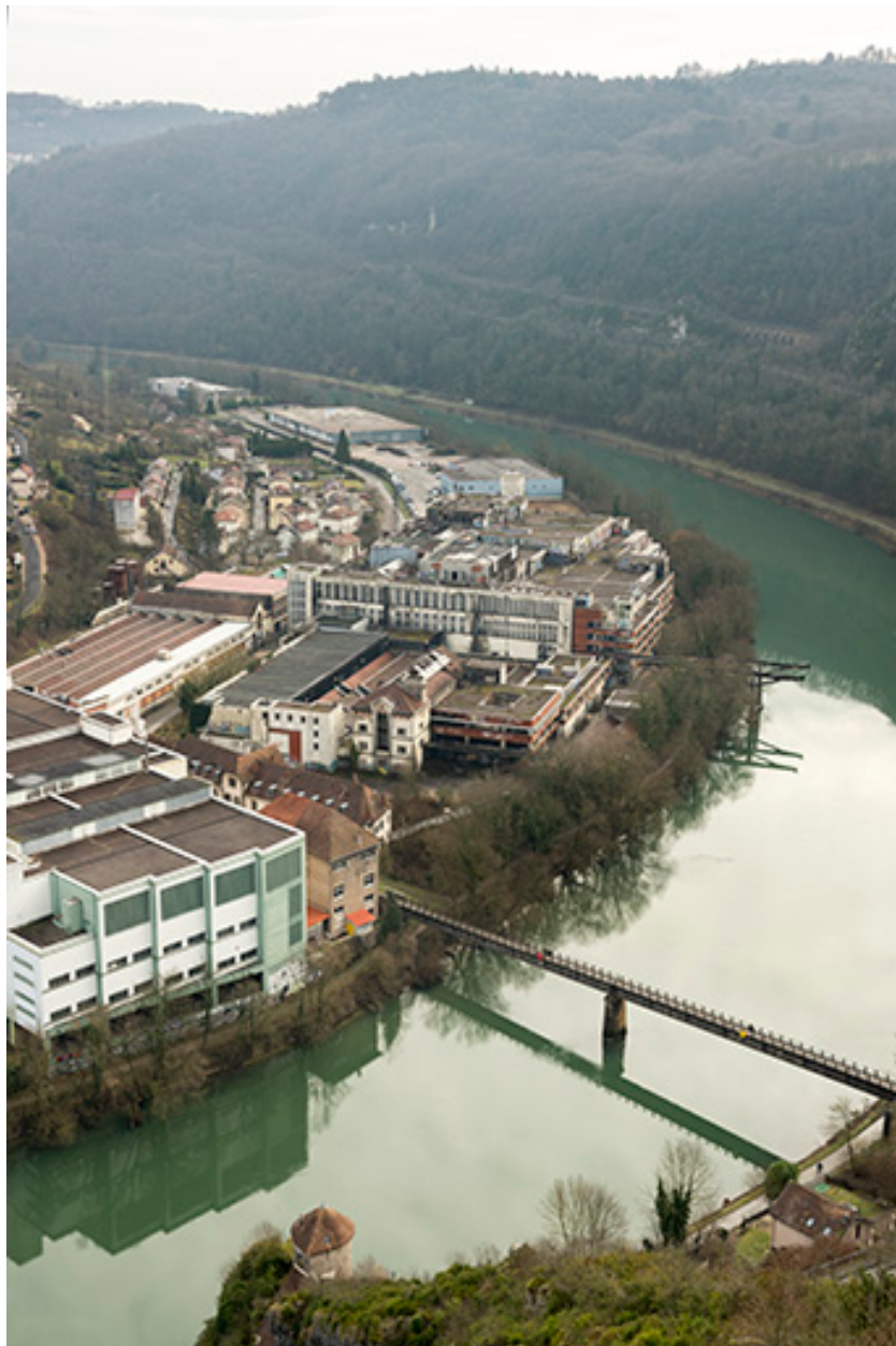
Etat en 2016. Usine A, vue de l'ouest (cadrage vertical).
