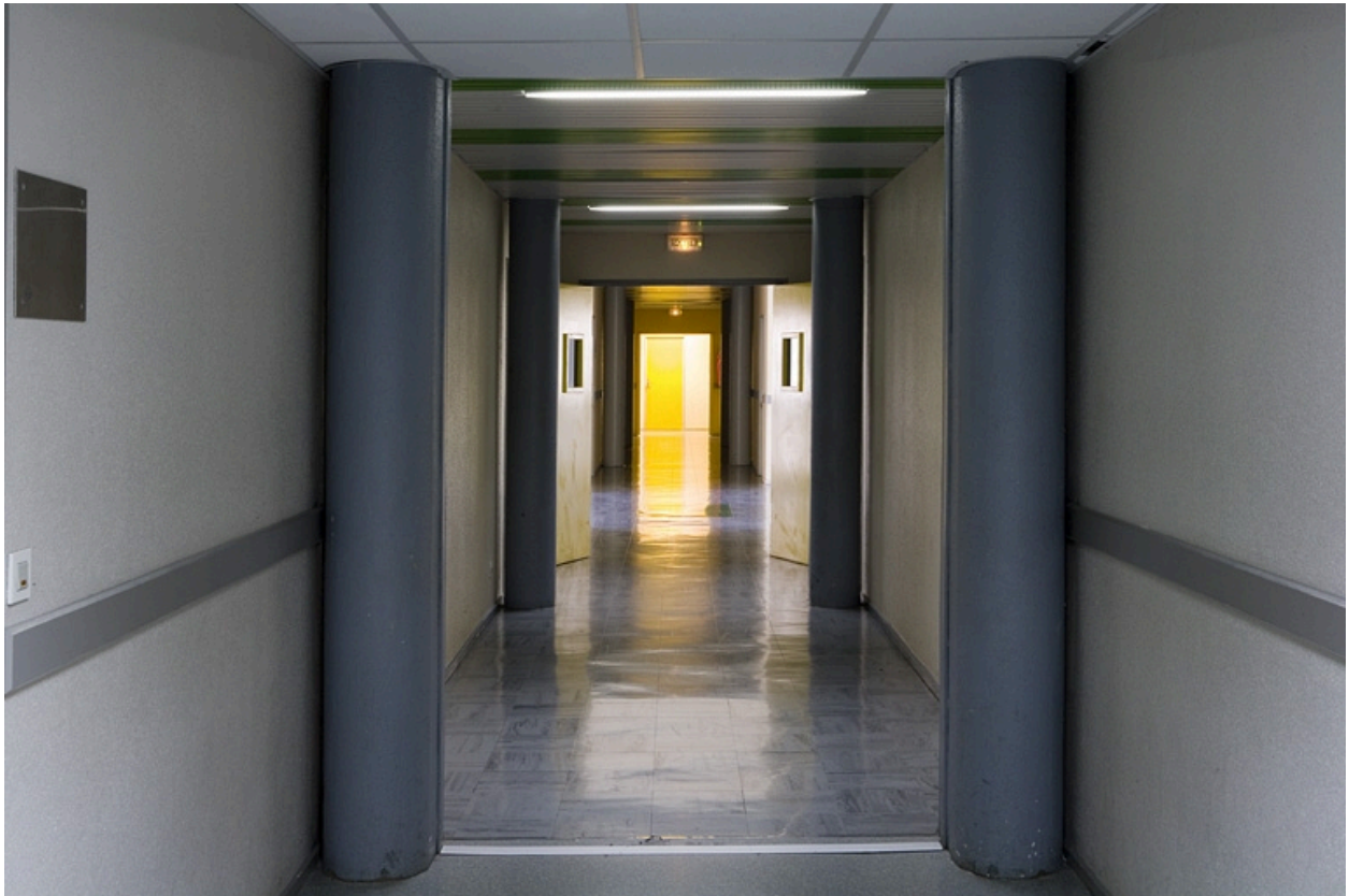
Site récent, bâtiment des laboratoires et du pôle bijouterie : couloir.
