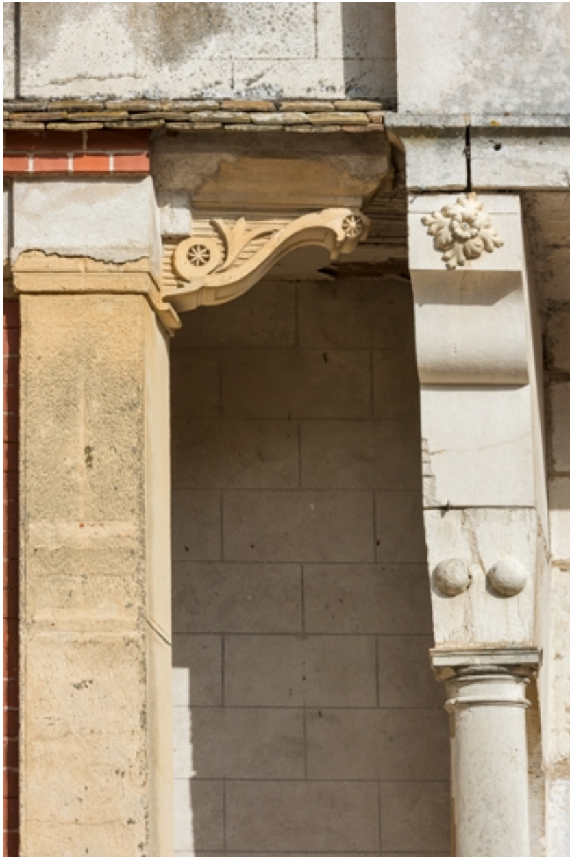
Galerie : supports côté cour.
