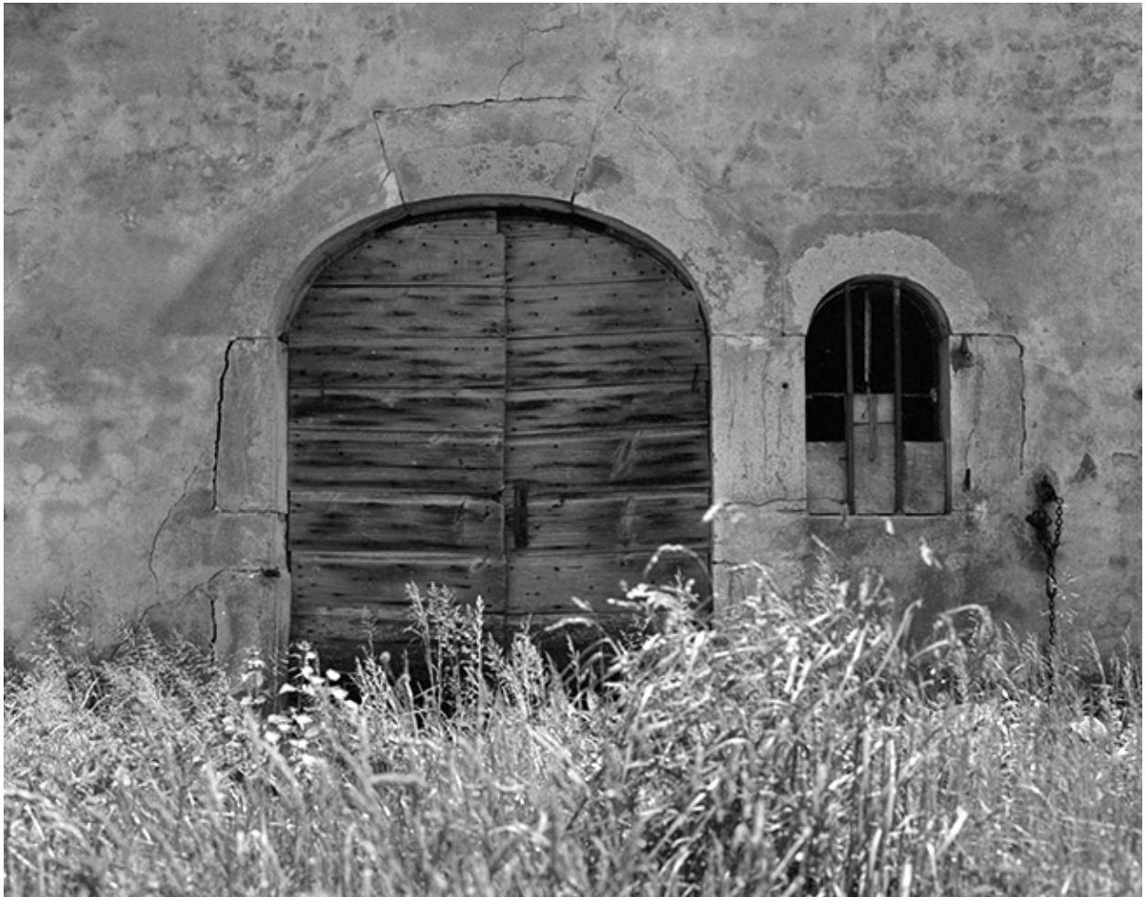
Détail : porte et fenêtre de l'étable en 1979.
