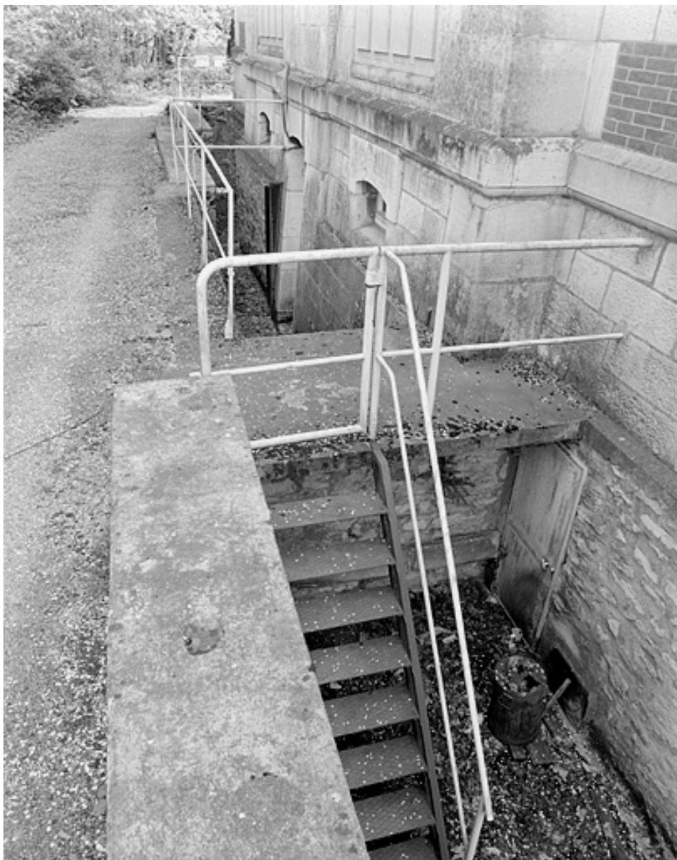
Fossé et escaliers d'accès au sous-sol.
