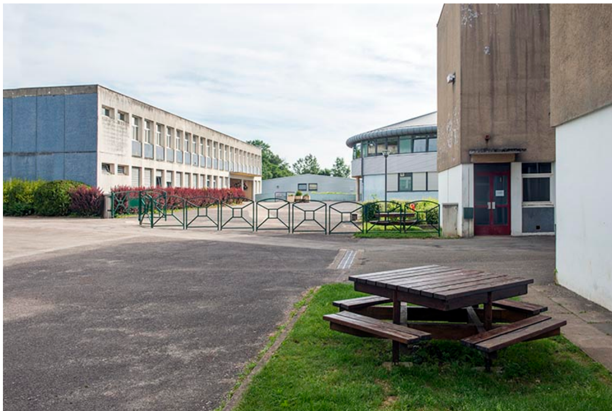
Cour devant l'entrée de l'internat-restauration.
