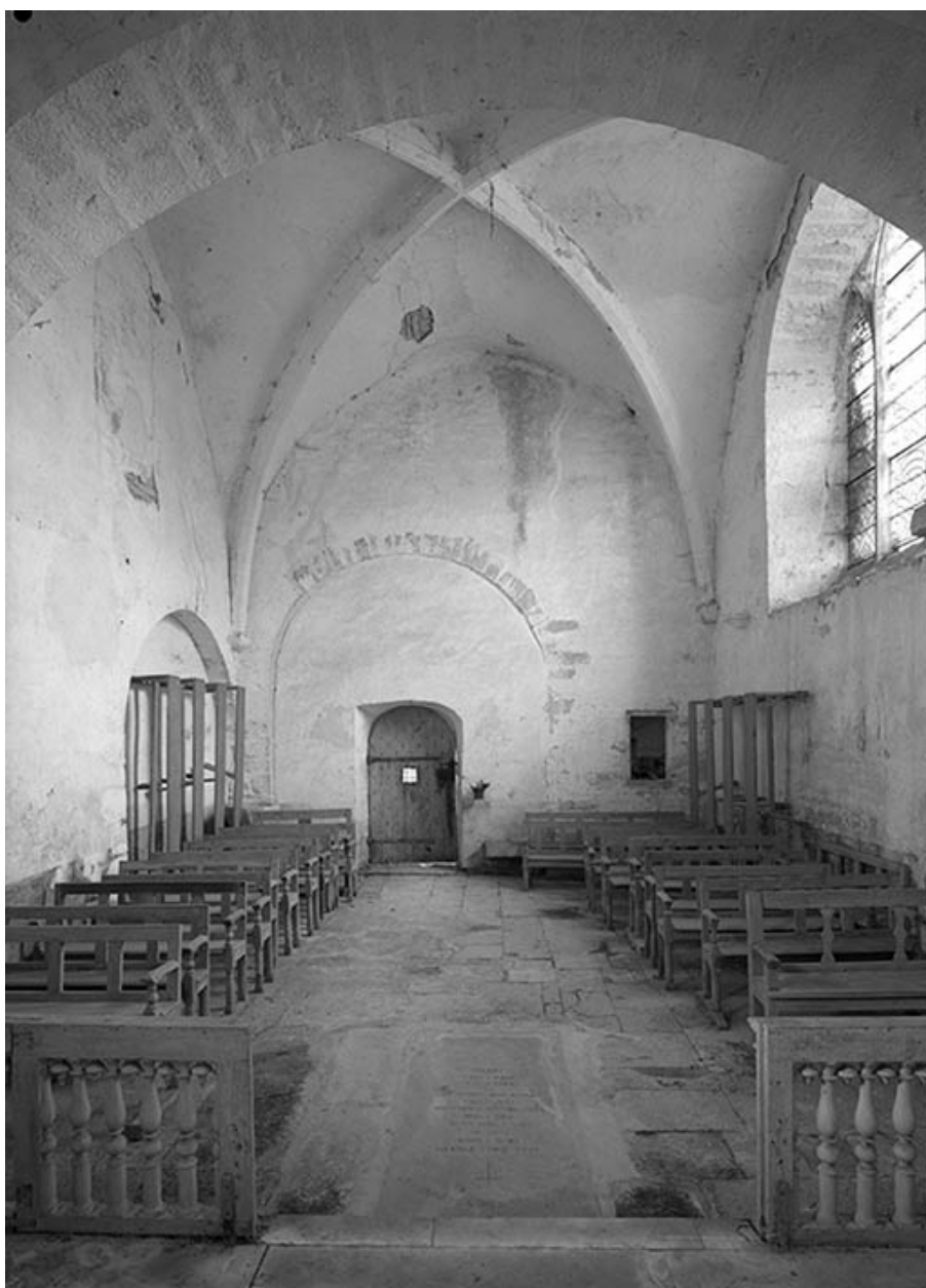
Nef, vue depuis le chœur.
