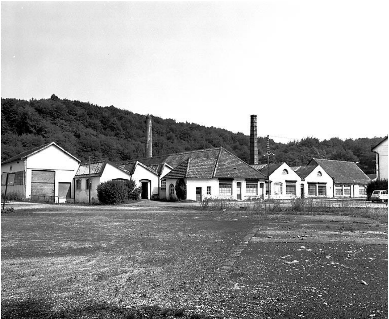
Ateliers de fabrication depuis le sud-ouest en 1981.
