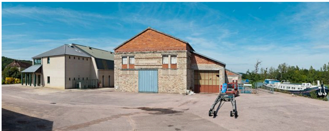
Vue de l'ancienne usine à chaux.
