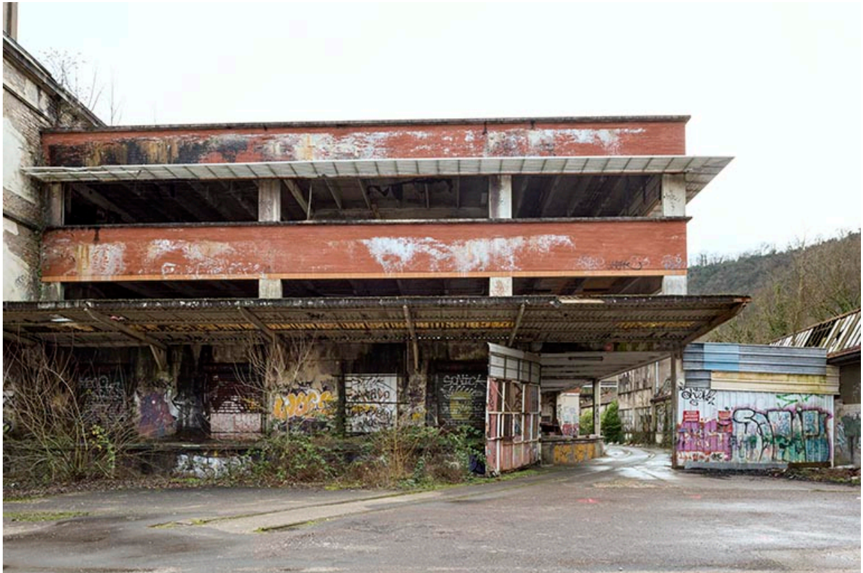
Etat en 2016. Usine A : angle sud-ouest de la cantine.
