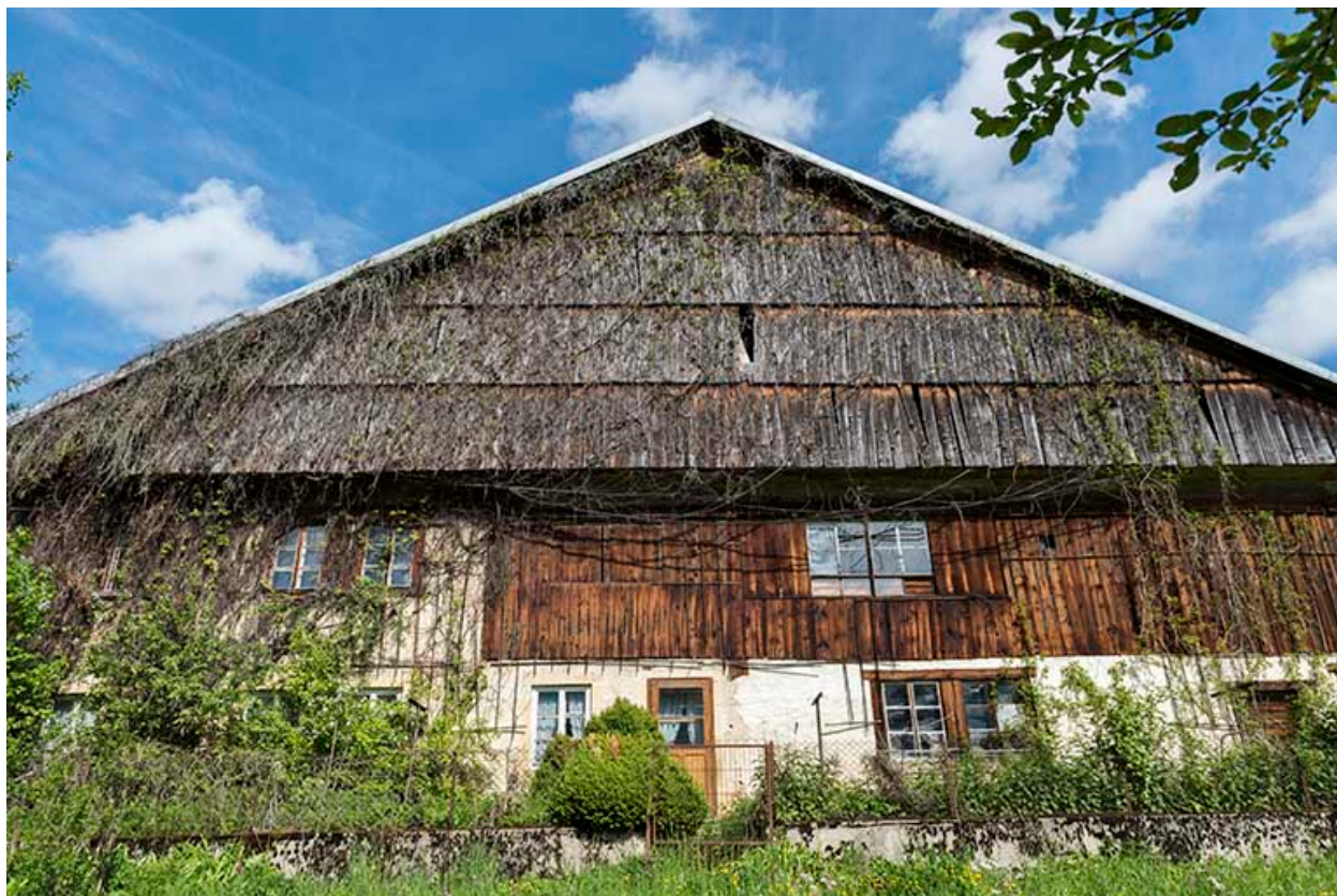
Façade antérieure, vue en contre-plongée.
