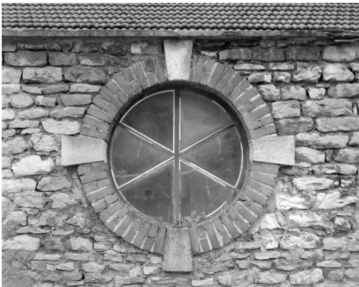
Atelier de fabrication ouest : détail d'un oculus.
