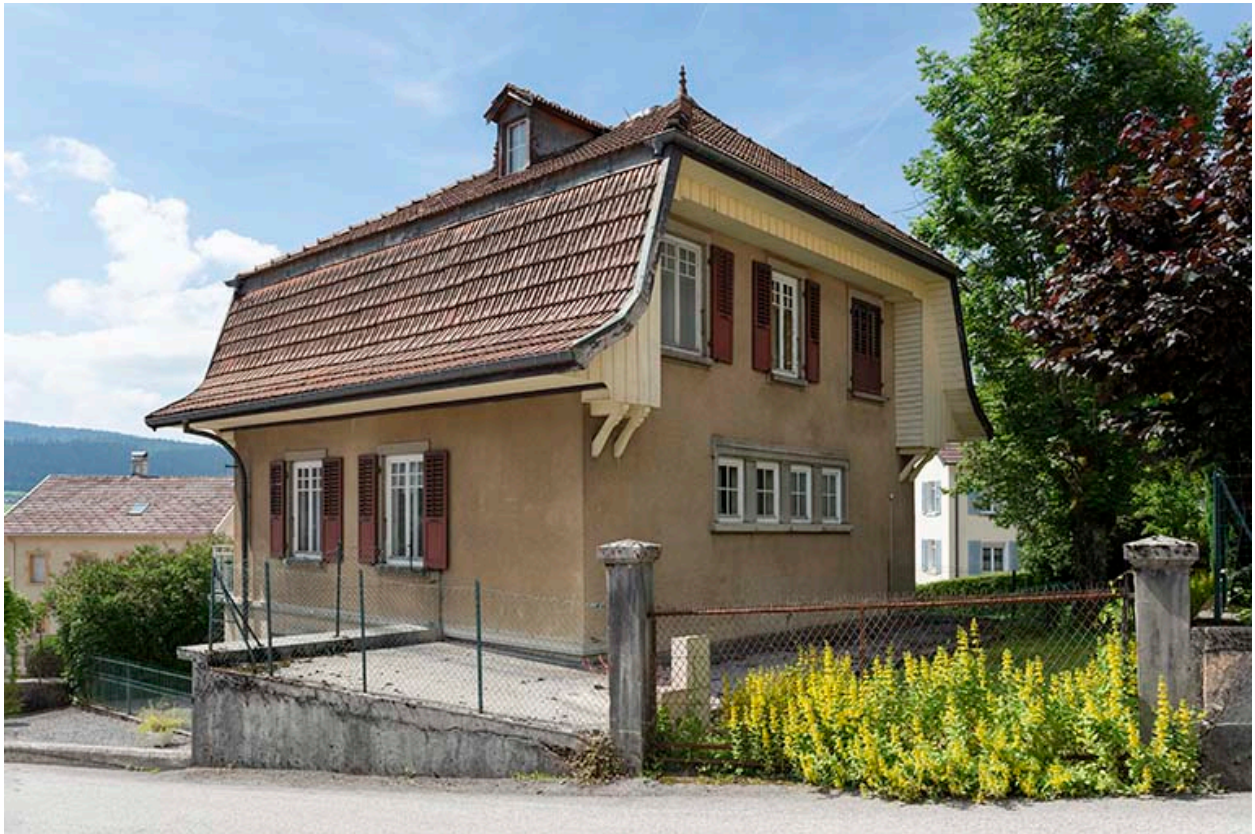
Façades postérieure et latérale droite.
