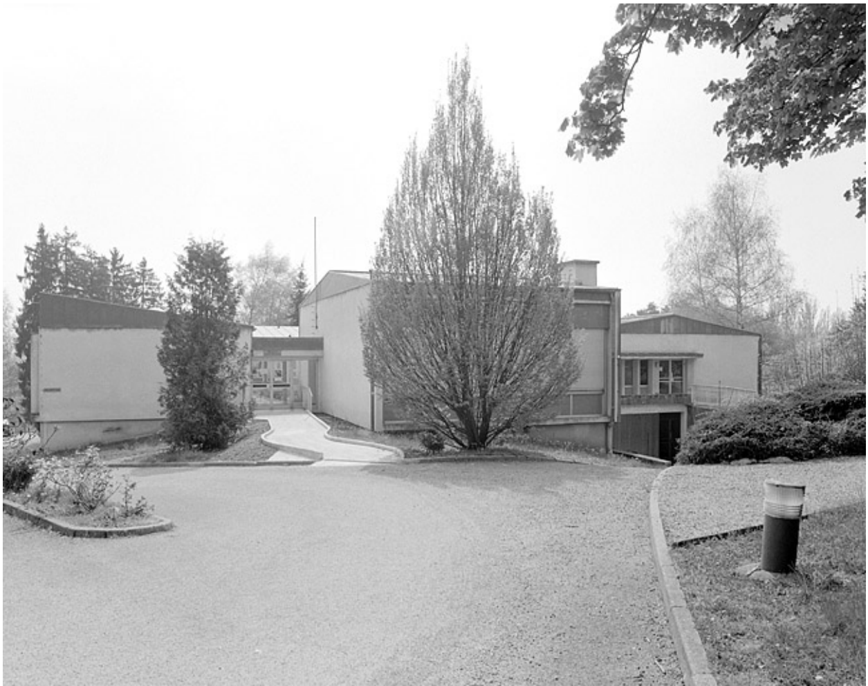
Partie sud : laboratoire d'essais et bureaux.
