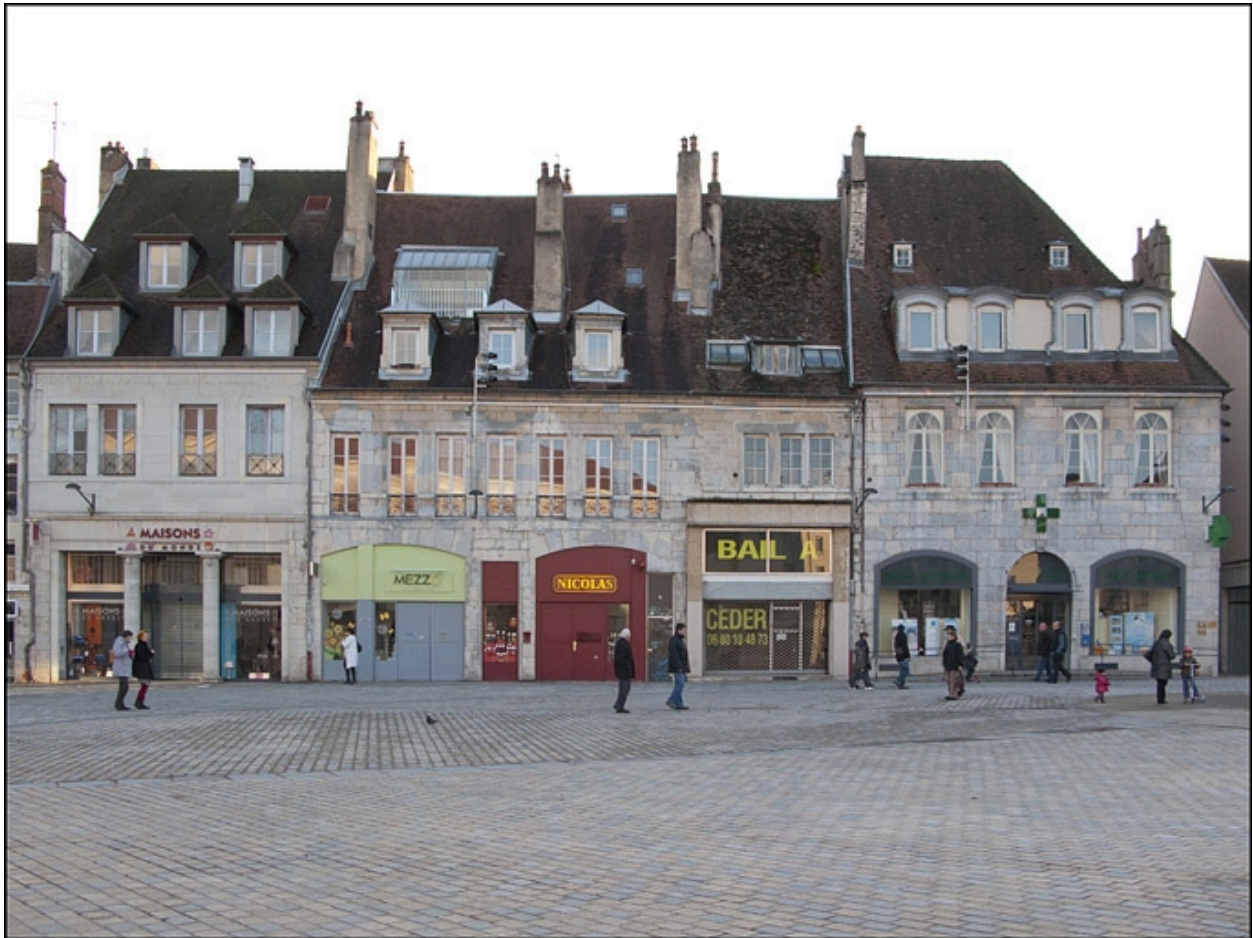
Vue d'ensemble de la façade antérieure dans l'alignement de la place.
