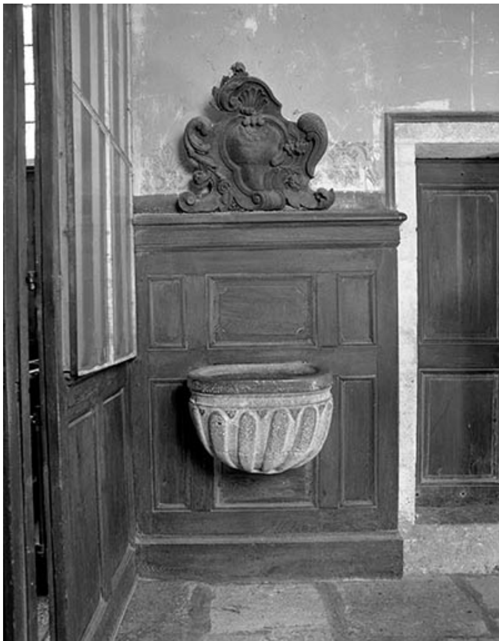
Boiseries du rez-de-chaussée de la tour-clocher.
