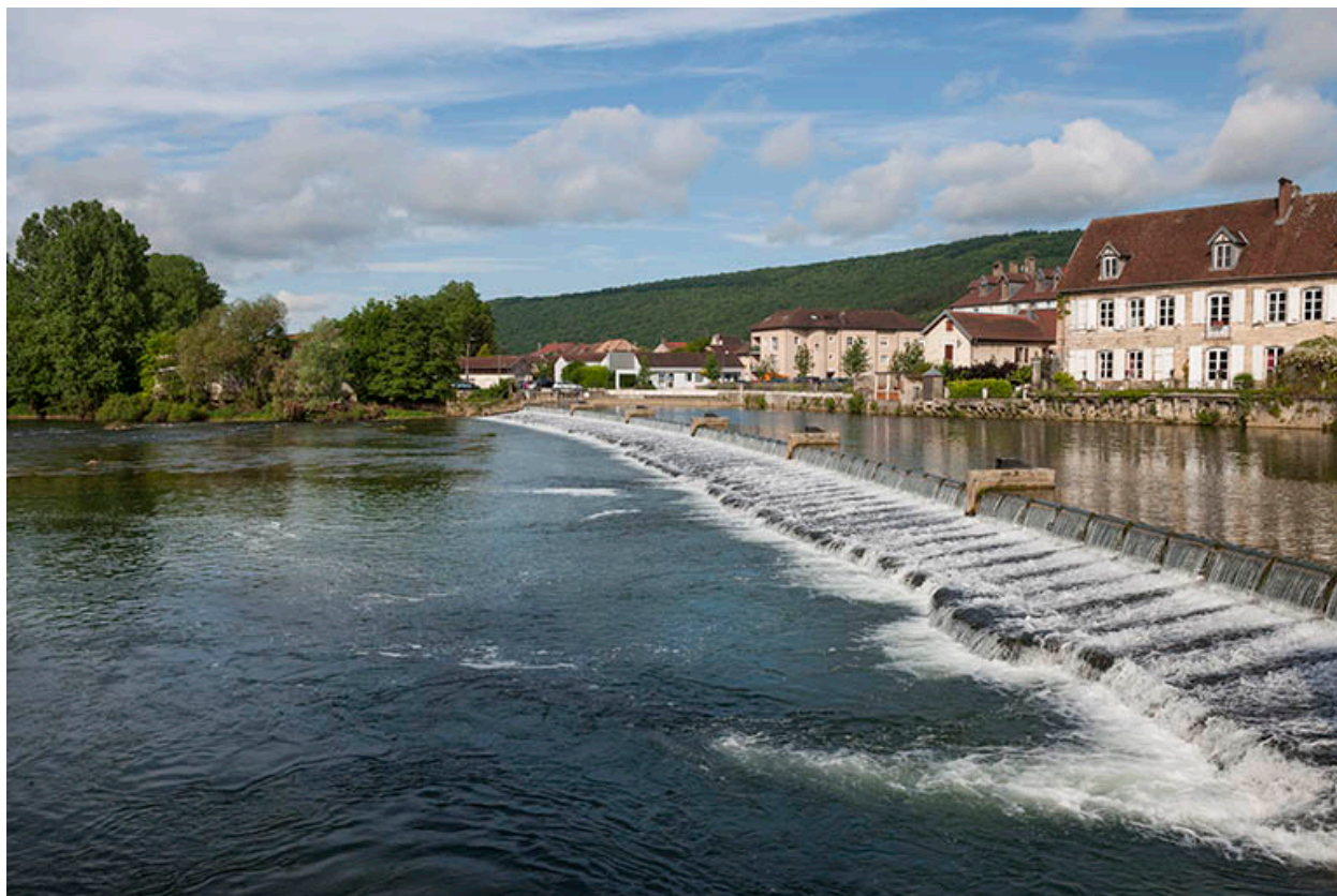
Vue du barrage depuis le pont.
