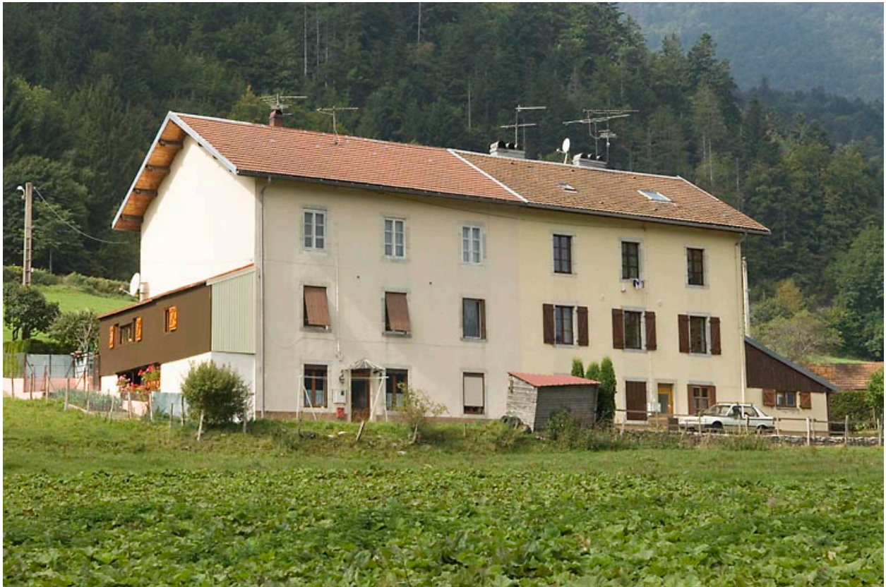
Immeuble à logements, façade postérieure.
