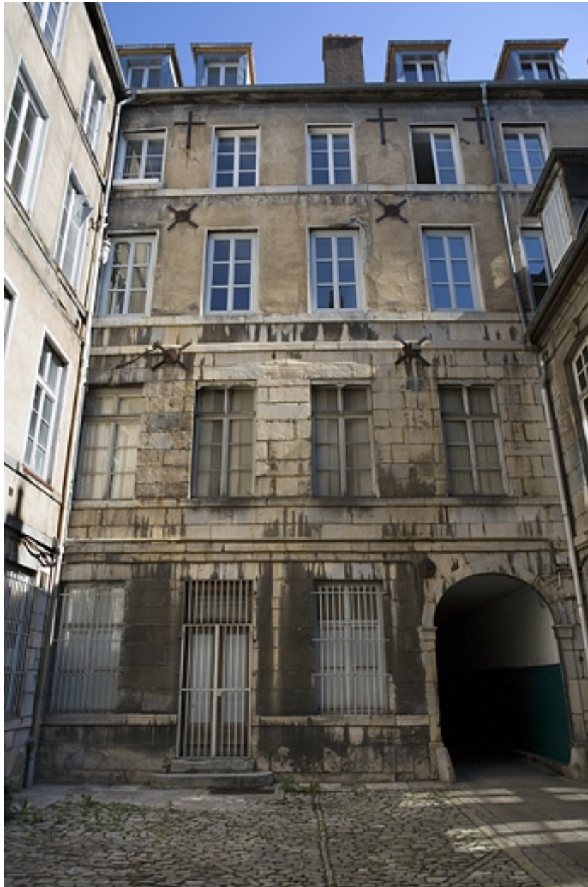
Vue d'ensemble de la façade postérieure du logis sur rue, de face.
