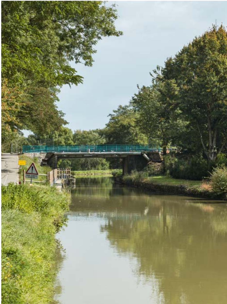
Vue d'ensemble du pont.
